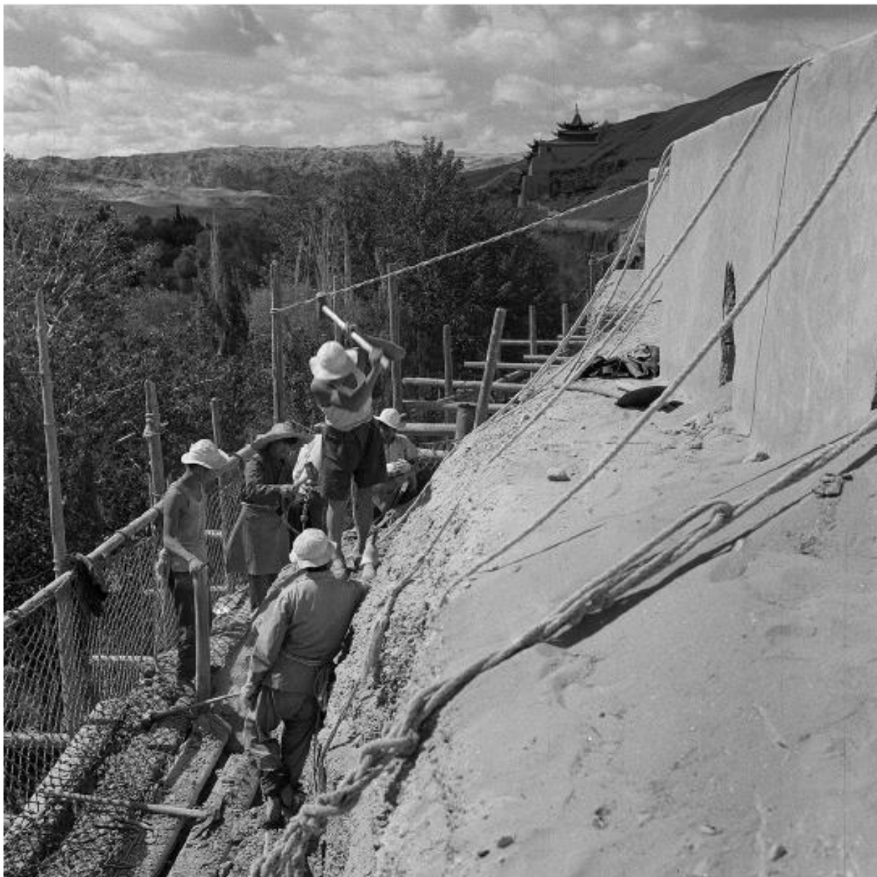
Hình 17. Công tác gia cố khối đá và dọn bỏ lớp đá bột tại phần đỉnh hang, tháng 7 năm 1965.
