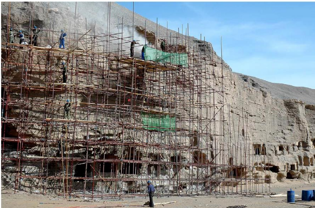
Hình 19. Công tác gia cố khu vực hang phía Bắc năm 2004.
