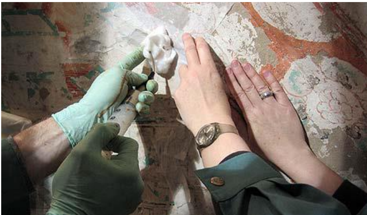
Hình 21. Công tác bơm vữa gia cố các bích họa.
