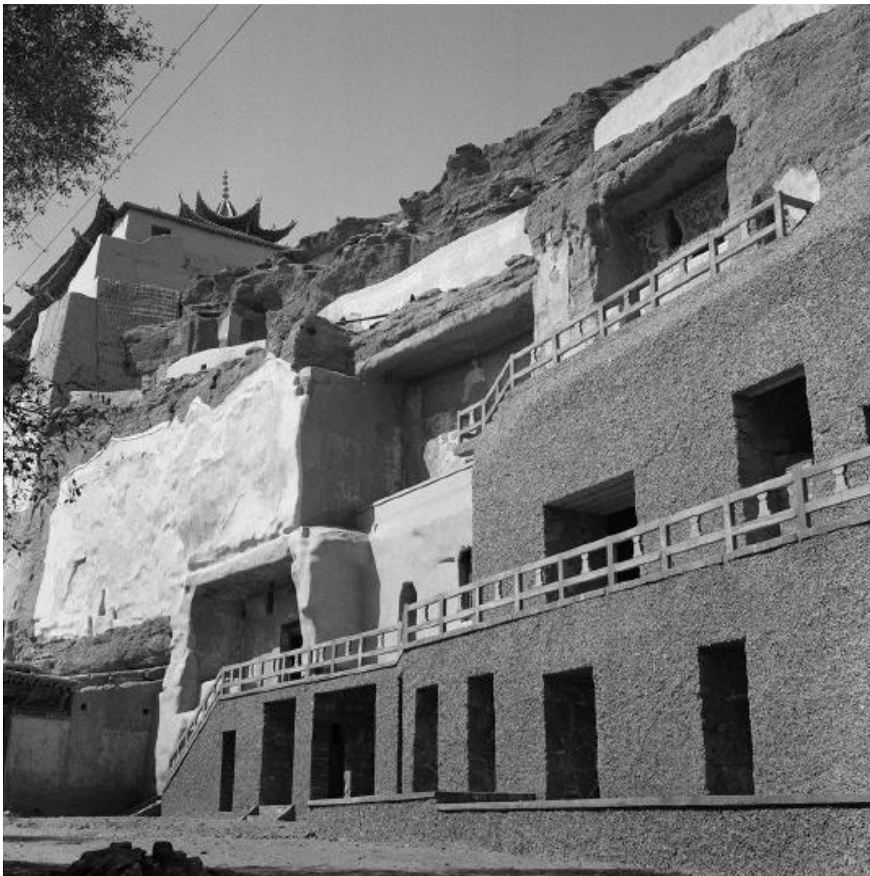
Hình 18. Quần thể hang Mạc Cao năm 1966, sau khi hoàn tất công tác gia cố kết cấu.
